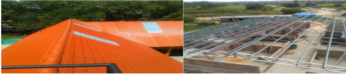
Cubierta edificio Administrativo y Cubierta caballerizas en Fuerte Carabineros Suba Gaitana
