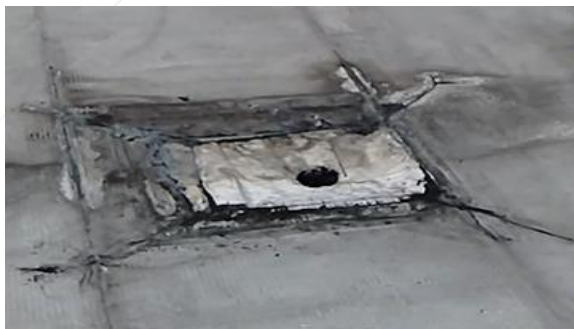
Imágenes 1 y 2. Sello deficiente en manto de impermeabilización que estarían provocando filtración de agua
