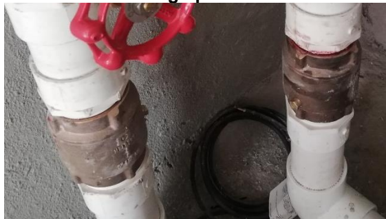
Imagen 17. Ítem NP-135. Válvula de pie 6" BR Antigolpe de ariete.
