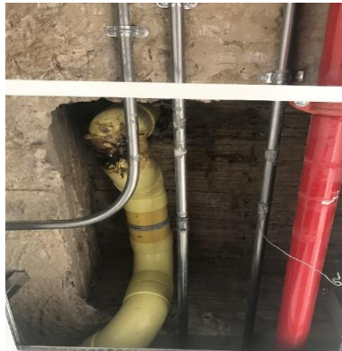
Imágenes 3 y 4. Desagües que estarían provocando filtración de agua
