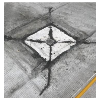
Imágenes 1 y 2. Sello deficiente en manto de impermeabilización que estarían provocando filtración de agua
