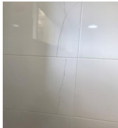
Imágenes 17 y 18. Cerámica y muro fracturados.
