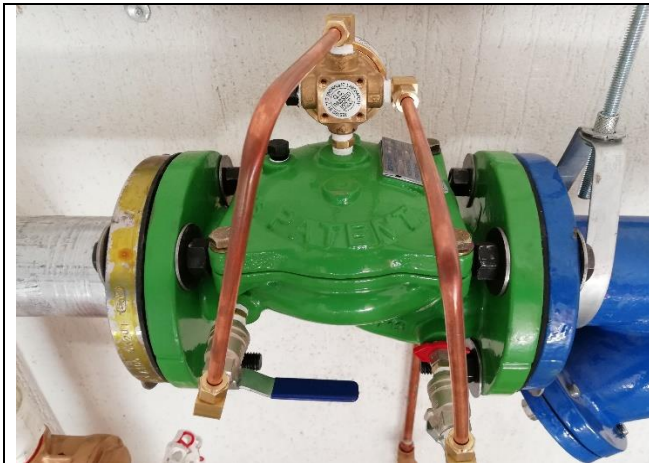
Imagen 4. Ítem 7.9.1. Válvula reguladora bridada \varnothing 3.
