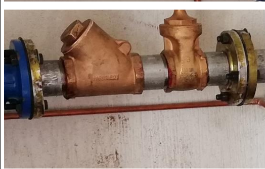
Imagen 7. Ítem 7.9.13. Brida en acero al carbón diámetro 3”.
