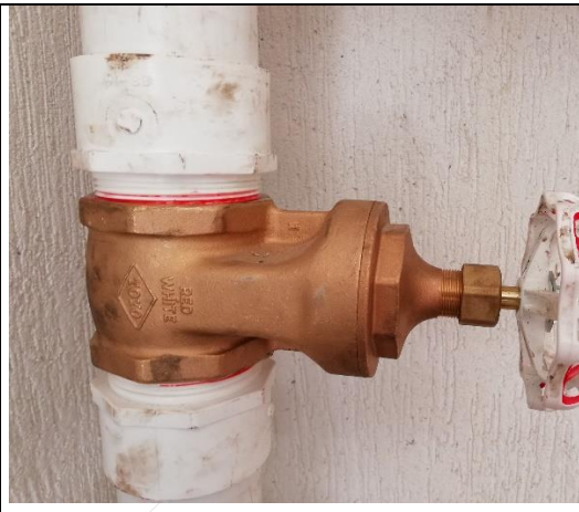
Imagen 5. Ítem 7.9.2. Válvula P/D RED White tipo pesado \varnothing 3”.
