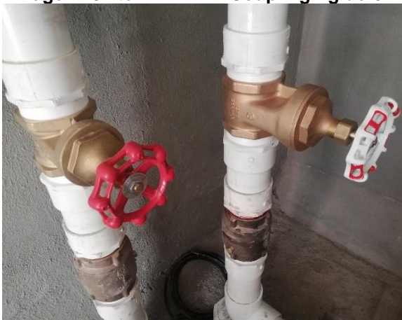
Imagen 12. Ítem NP-128. Válvula de retención cheque 3" incluye accesorios
