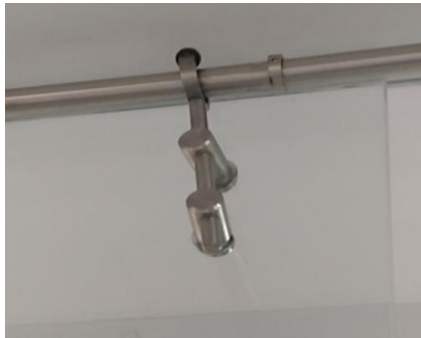
Imágenes 15 y 16. Herrajes sueltos en los sistemas de puerta corrediza.
