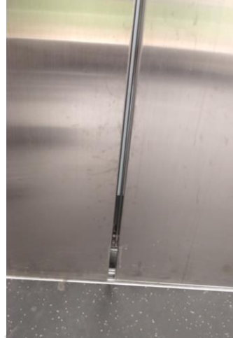
Imágenes 19 y 20. Defectos en el sistema de cierre del ascensor.
