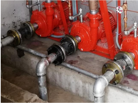
Imagen 20. Ítem NP-138. Junta de expansión tipo unión flexible \varnothing 2".
