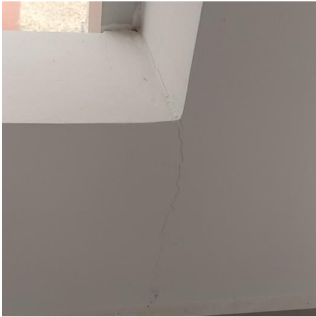
Imágenes 9 y 10. Fisuras en vanos de ventanas y cielos rasos
