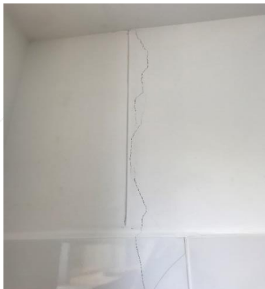
Imágenes 17 y 18. Cerámica y muro fracturados.
