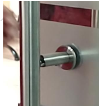
Imágenes 15 y 16. Herrajes sueltos en los sistemas de puerta corrediza.
