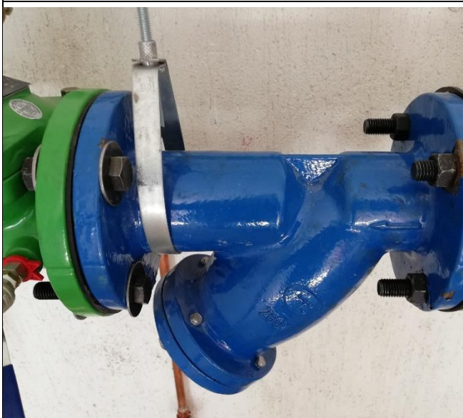
Imagen 4. Ítem 7.9.1. Válvula reguladora bridada \varnothing 3.
