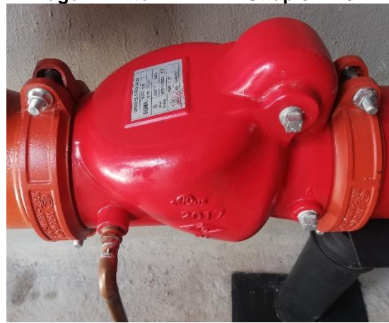
Imagen 13. Ítem NP-129. Válvula de retención cheque 6" incluye accesorios coupling.
