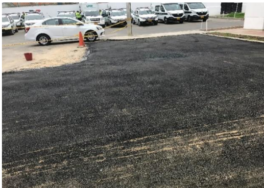
Imagen 37. Carpeta asfáltica recién aplicada - parqueadero (imagen de archivo, visita octubre de 2018)
