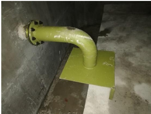
Imagen 27. Placa anti vórtice 6" de 50*50cm en acero inoxidable
