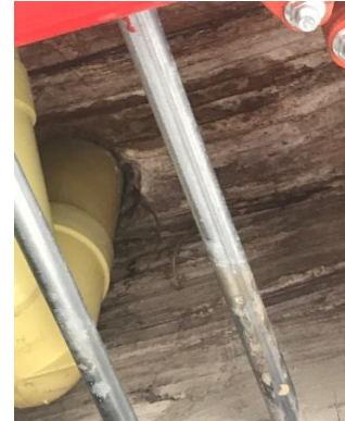
Imágenes 3 y 4. Desagües que estarían provocando filtración de agua
