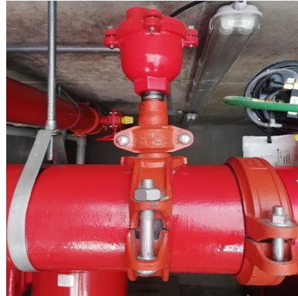
Imagen 21. Ítem NP-140. Junta de expansión tipo unión flexible \varnothing 2".
