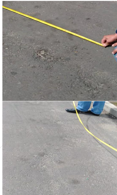
Imágenes 31 a 34. Fallas generalizadas en la carpeta asfáltica acceso principal
