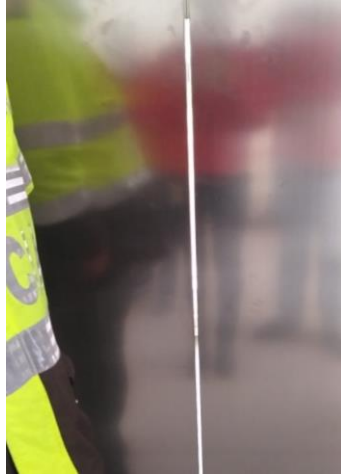
Imágenes 19 y 20. Defectos en el sistema de cierre del ascensor.
