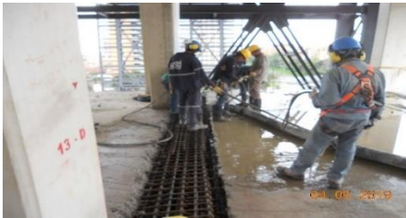
Fundida de recalce de viga y placa
