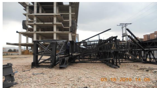
Desmonte estructura metálico costado oriental
