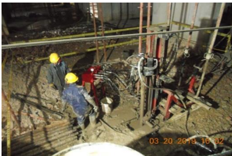
Pruebas pilotaje bajo placa en sótano
