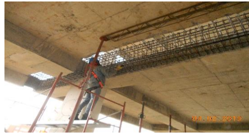
Apuntalamiento y armado de refuerzo
