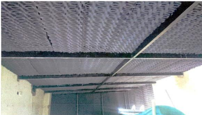
Recubrimiento con espuma flexible en muros y techo del laboratorio Balístico
