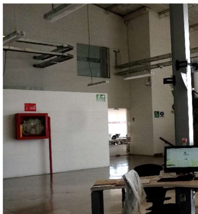
Fotografía 97 Sistemas de extinción de incendios de acción manual
