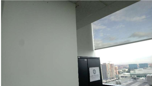
Fotografía 67 Muros perimetrales en concreto
