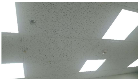
Fotografía 65 Techo de espacios del Nivel central.
