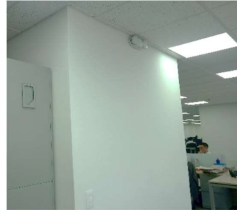
Fotografía 68 Muros divisorios (falsos).
