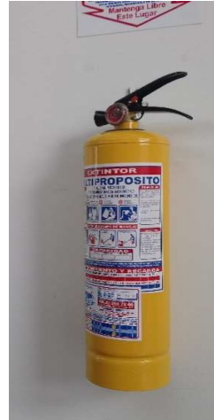
Fotografía 82 Sistema manual de extinción de incendio
